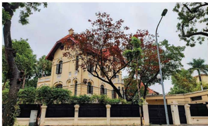
Biệt thự ở phố Điện Biên Phủ, Ba Đình, Hà Nội, một công trình di sản kiến trúc được trùng tu thích ứng trong bối cảnh mới (3)
